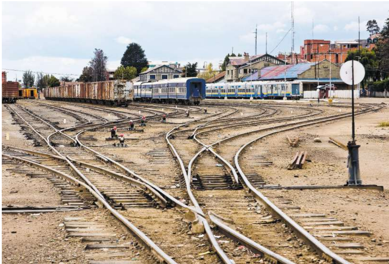
Eisenbahnlagen zu bauen, ist in Bolivien eine Herausforderung, aber es gilt als möglich: Zugdepot in Oruro.
